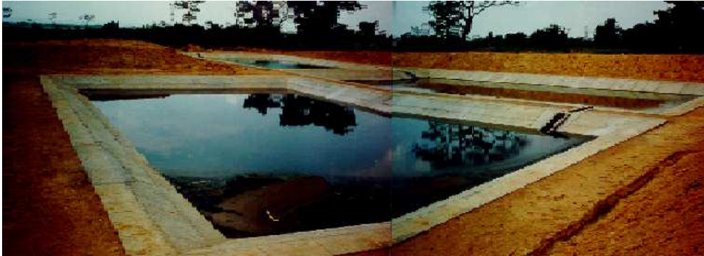
Lagunas de Oxidación
