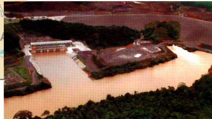
Casa de Máquinas
