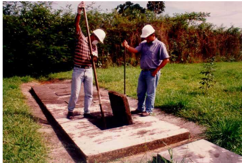
Construcción de Pozos Sépticos
